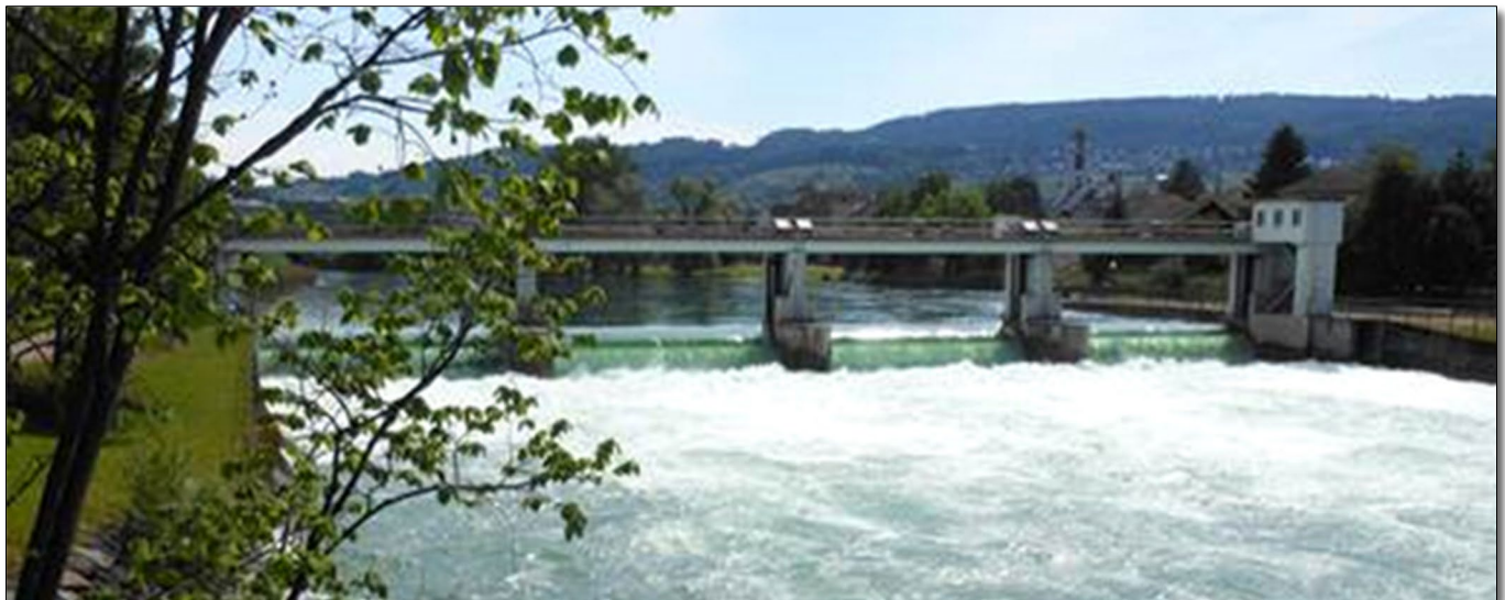
Stauwehr • Kraftwerk EKZ • Regen und die Schneeschmelze in den Bergen bringen im Mai und Juni viel Wasser
